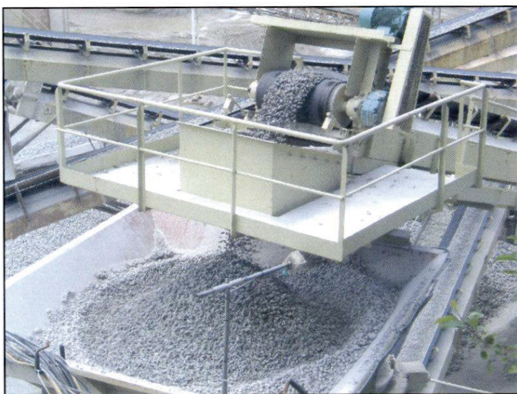
Fot.2: Vista de pormenor da instalação de britagem
